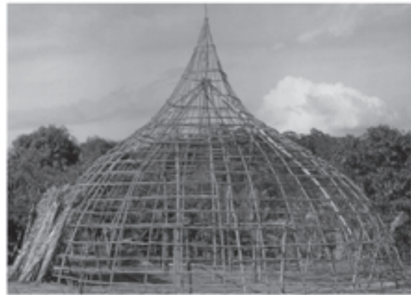
Vista de la estructura
