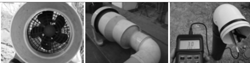
Foto 5 Colocación de ventiladores y medición velocidad del caudal
