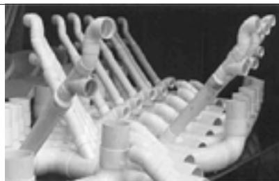
Fotos 15 y 16 Redes de evacuación prearmada PVC 3.2 y red de provisión de agua, (araña) con tubería flexible.
