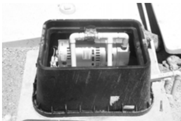
Foto 5 Soplador de émbolos rotativos de la planta prototipo
