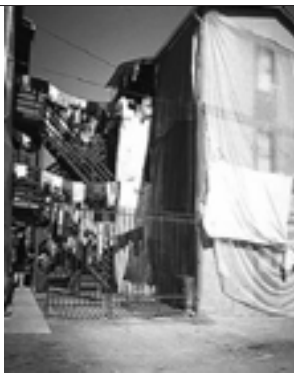
Foto 8 Urbanización Los Quiyalles, Chile. Ampliaciones anárquicas que ponen en riesgo la totalidad de la edificación y por consiguiente de sus habitantes. Véanse las ampliaciones resaltadas en la imagen por ambas fachadas de la edificación, cada una es diferente con respecto a la otra.
