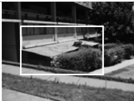
Foto 12 Ampliaciones en las plantas bajas de los block. Distíngase que todos los techos son livianos, imposibilitando –momentáneamente– las ampliaciones de los apartamentos de los pisos superiores.
