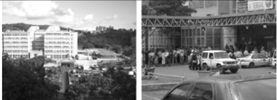
Figura 12 Hospital Domingo Luciani. IVSS. Vista general, espera de familiares y acceso de la emergencia
