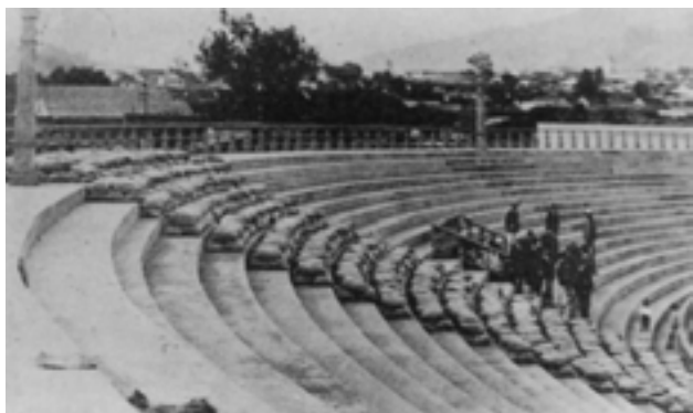
Foto 1 Prueba de carga en la gradería durante la construcción del Nuevo Circo.
