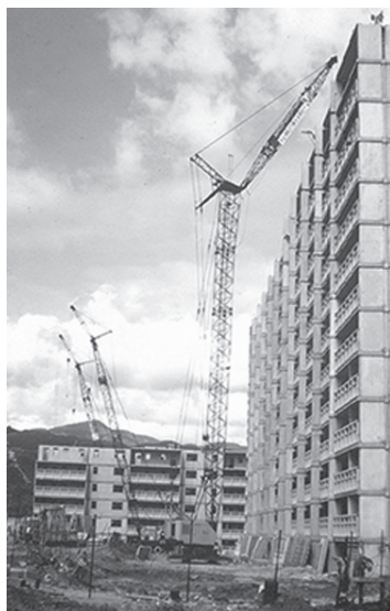
Foto 4 Sistema A4-M de Vivienda Venezolana. Paredes portantes prefabricadas y losas prefabricadas y postensadas para edificios prefabricados de hasta 4 pisos. Foto: archivo IDEC.
