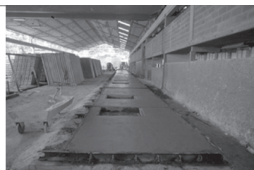
Foto 5 Producción en planta de los componentes de paredes portantes del sistema A4-M de Vivienda Venezolana. Foto: Nancy Dembo.
