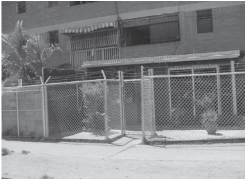
Foto 4 Refacciones en las fachadas de los edificios multifamiliares.
