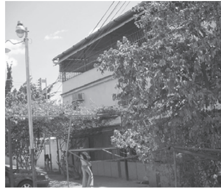
Foto 3 Crecimiento informal de la vivienda a tres plantas.
