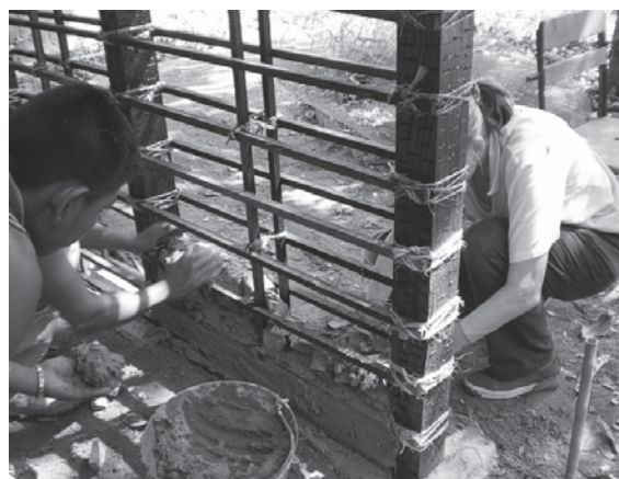
Foto 11 Rellenando el panel
