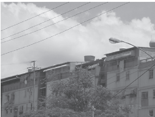
Foto 6 Se puede observar crecimientos en los apartamentos superiores.
