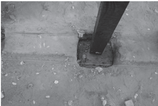
Foto 3 Horcón enterrado y relleno de concreto
