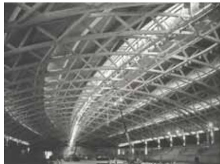
Foto 10. Detalle de la estructura del techo del Pabellón Olímpico de Hamar.
