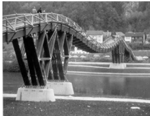
Foto 5. Pasarela con madera laminada sobre el canal Rhin.
