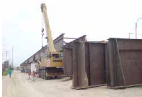
Foto 1. Vigas de acero de gran peralte para la construcción del Tren Puerto Cabello-La Encrucijada.
