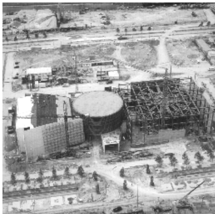
PABELLÓN DE LA UTOPIA
