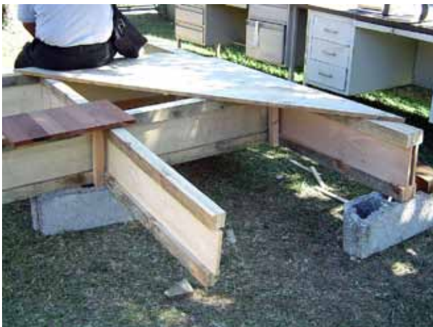
Foto 3. Componentes viga principal y secundaria
