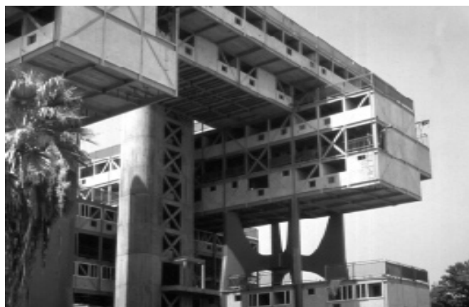
Edificio de vivienda en Puerto La Cruz. Estructuras límites de Fruto Vivas
