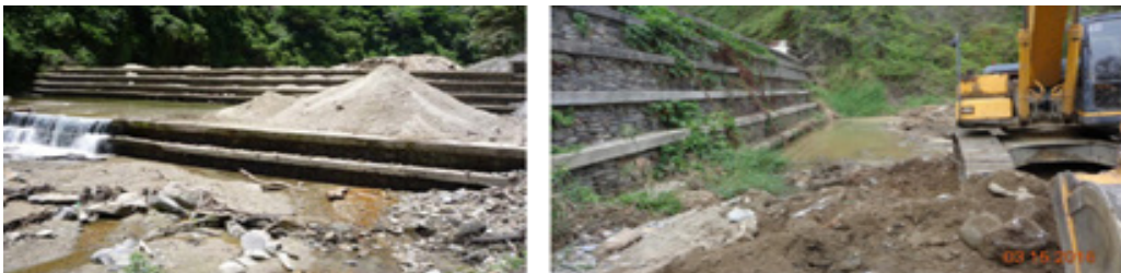
Figura 29. Extracción inadecuada de material sedimentario entre el dique y el contradique de presa en el río Migueleno (Sanabria, 2016), con lo cual se elimina la capa protectora del dique.
