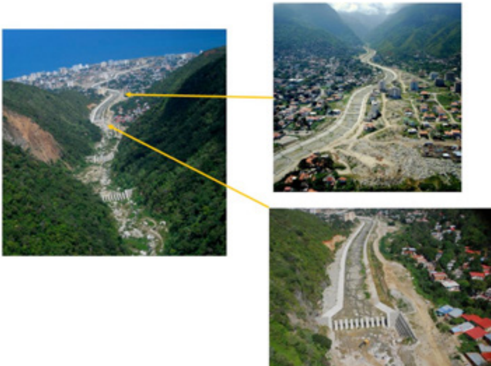
Figura 8. Vista aérea de las obras de control en el río San Julián, mostrando: a) el canal de fondo móvil protegido con traviesas para control de erosión y con recubrimiento de concreto en las márgenes; y b) tres presas abiertas para retención de sedimentos. Fotos izquierda e inferior miran hacia aguas abajo. Foto derecha mira hacia aguas arriba (López y Courtel, 2012).
