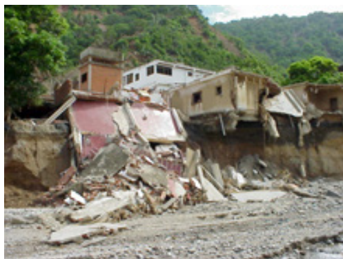
Figura 4. Daños producidos por erosión del flujo en Carmen de Uria (izquierda) y por impacto de peñones en Los Corales (derecha).
