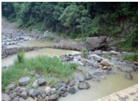
Figura 22. Fallas en contradiques de Presa N° 2 en Río Migueleno (foto izquierda, mirando desde aguas arriba) y en Presa N° 1 en río Cerro Grande (derecha, mirando desde aguas abajo) (2011).
