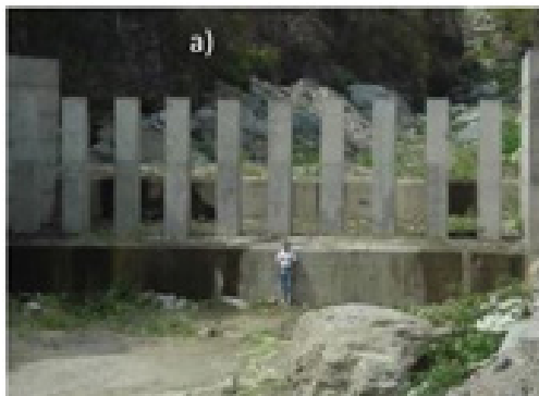
Figura 9. Presa abierta ranurada en la quebrada Guanape: a) vista frontal desde aguas abajo después de finalizada la construcción en mayo 2001; b) después de la creciente de Diciembre 2001; c) vista desde aguas arriba del vaso sedimentado en diciembre 2001; y d) vista desde aguas abajo después de la creciente de febrero 2005, mostrando la capacidad de auto-limpieza de la presa capaz de remover los sedimentos atrapados.
