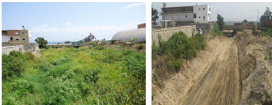
Figura 18a. Vista (izq.) de la canalización del río San Julián en Los Corales mostrando el grado de colonización por la vegetación, induciendo a la sedimentación (foto 2014) y vista (der.) después de la remoción del material en un tramo cercano a 300 m de longitud, 15 m de ancho y 2 m de profundidad (foto 2016 de Mariela Gómez).
