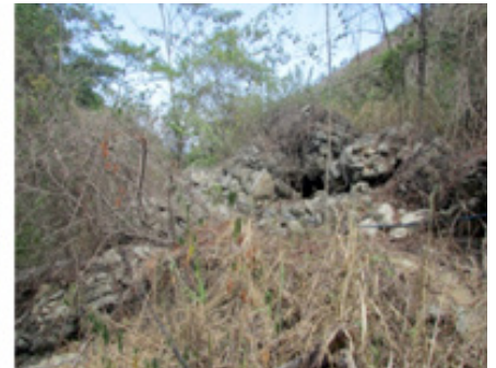
Figura 21. Restos de la presa de gaviones en Quebrada Seca destruida por las lluvias del 2010 y 2013 (foto tomada en marzo, 2016).
