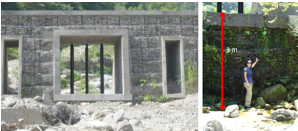
Figura 18a. Vista (izq.) de la canalización del río San Julián en Los Corales mostrando el grado de colonización por la vegetación, induciendo a la sedimentación (foto 2014) y vista (der.) después de la remoción del material en un tramo cercano a 300 m de longitud, 15 m de ancho y 2 m de profundidad (foto 2016 de Mariela Gómez).
