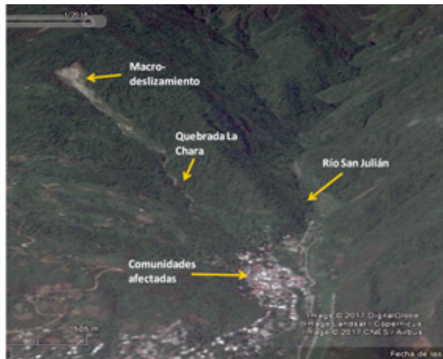
Figura 31. Deslizamiento reciente, intensificado a consecuencia de las lluvias del 2011, en la cuenca del río San Julián, quebrada La Chara, sector Caraballeda. Imagen Google Earth.
