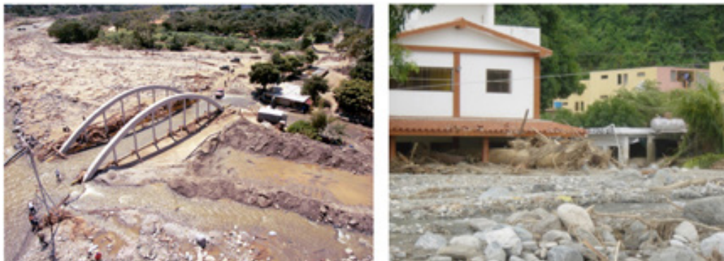
Figura 14. Efecto de las lluvias de febrero 2005 en la zona de Camurí Grande cuando no se habían construido las obras de protección. Observe la obstrucción y colmatación del puente por arrastres vegetales y sedimentos (izquierda) y daños en viviendas aledañas (derecha).
