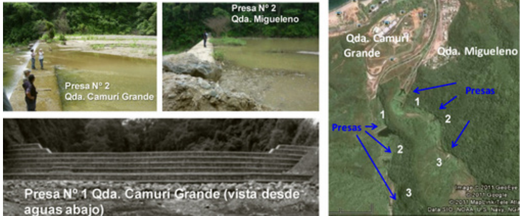
Figura 15. Presas de retención de sedimentos y canalización construida en los ríos Camurí Grande y Migueleno, entre los años 2006 y 2007, para proteger a la población de Camurí. Observe el grado de sedimentación total de las presas después de la creciente de finales de 2010 (fotos tomadas en 2011).
