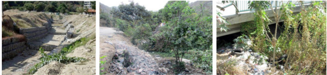
Figura 36. Construcción de viviendas informales y bote de desechos sólidos en la franja protectora de la canalización de la quebrada Curucutí en Maiquetía (Protección Civil Vargas, 2014).
