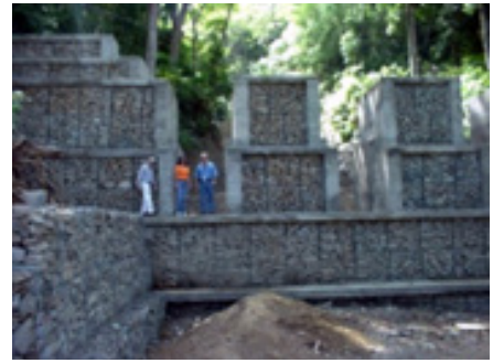
Figura 7. Fotografías de diferentes tipos de presas abiertas construidas en Vargas: a) presa ranurada, tipo rastrillo, de gaviones en quebrada Piedra Azul; b) presa de gaviones con ventanas en río Camurí Chico; c) presa tipo rastrillo de concreto armado en quebrada Guanape; d) presa tipo rastrillo de concreto armado en río San Julián; e) presa tipo enrejado de concreto armado en la quebrada San José de Galipán; y f) presa ranurada de concreto ciclópeo en la quebrada Curucutí. g) presa cerrada de gaviones (dique y contradique) en la quebrada Alcantarilla; h) presa cerrada de gaviones, provista de barbacanas, en quebrada Seca; i) presa cerrada de gaviones, provista de barbacanas, en quebrada Camurí Grande; j) presa abierta del tipo rastrillo, con elementos tubulares de acero en la quebrada Tacagua; y l) presa tipo barrera flexible (Geobrugg) en quebrada Osorio.
