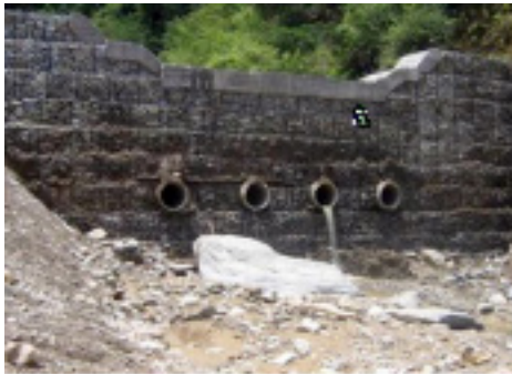
Figura 22. Fallas en contradiques de Presa N° 2 en Río Migueleno (foto izquierda, mirando desde aguas arriba) y en Presa N° 1 en río Cerro Grande (derecha, mirando desde aguas abajo) (2011).
