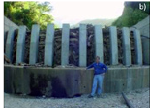
Figura 9. Presa abierta ranurada en la quebrada Guanape: a) vista frontal desde aguas abajo después de finalizada la construcción en mayo 2001; b) después de la creciente de Diciembre 2001; c) vista desde aguas arriba del vaso sedimentado en diciembre 2001; y d) vista desde aguas abajo después de la creciente de febrero 2005, mostrando la capacidad de auto-limpieza de la presa capaz de remover los sedimentos atrapados.
