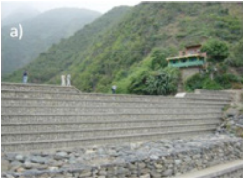
Figura 11. Acumulación progresiva de sedimentos aguas arriba de la presa de Macuto en la quebrada San José de Galipán: a) recién construida en marzo 2003; b) enero 2004; c) enero 2005; y d) febrero 2005.
