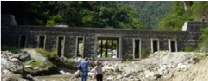
Figura 7. Fotografías de diferentes tipos de presas abiertas construidas en Vargas: a) presa ranurada, tipo rastrillo, de gaviones en quebrada Piedra Azul; b) presa de gaviones con ventanas en río Camurí Chico; c) presa tipo rastrillo de concreto armado en quebrada Guanape; d) presa tipo rastrillo de concreto armado en río San Julián; e) presa tipo enrejado de concreto armado en la quebrada San José de Galipán; y f) presa ranurada de concreto ciclópeo en la quebrada Curucutí. g) presa cerrada de gaviones (dique y contradique) en la quebrada Alcantarilla; h) presa cerrada de gaviones, provista de barbacanas, en quebrada Seca; i) presa cerrada de gaviones, provista de barbacanas, en quebrada Camurí Grande; j) presa abierta del tipo rastrillo, con elementos tubulares de acero en la quebrada Tacagua; y l) presa tipo barrera flexible (Geobrugg) en quebrada Osorio.
