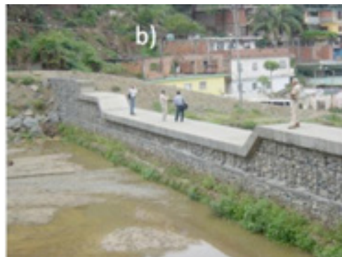
Figura 11. Acumulación progresiva de sedimentos aguas arriba de la presa de Macuto en la quebrada San José de Galipán: a) recién construida en marzo 2003; b) enero 2004; c) enero 2005; y d) febrero 2005.
