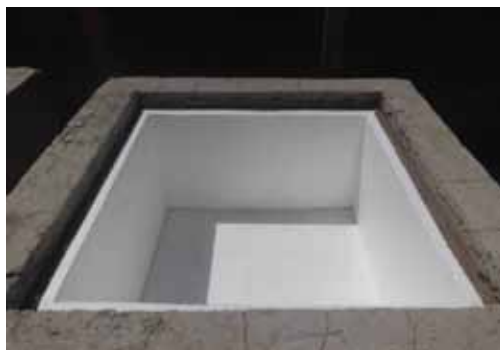
Figura 5. Aislamiento de los módulos con poliestireno expandido
