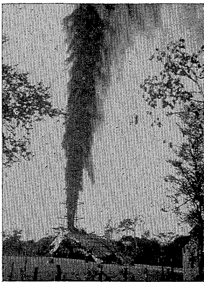
Fig. 1.—Compañía Shell de Venezuela. El 14 de diciembre de 1922, mientras era perforado, reventó el Pozo Barroso N° 2 en La Rosa (ahora R-4 de Cabimas), el cual estuvo fluyendo sin control, a razón de unos 100.000 barriles diarios, hasta que al cabo de 10 días las arenas subterráneas taponaron el pozo. Estado Zulia.
