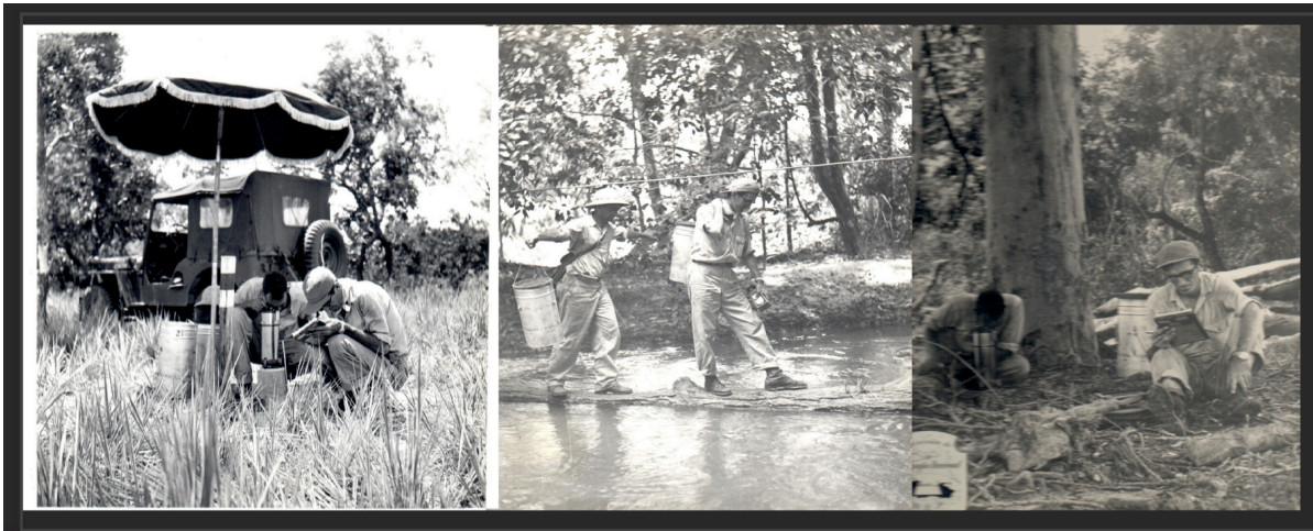
Fig. 6. Operadores de gravímetros en levantamiento de estaciones del Datum La Canoa.
