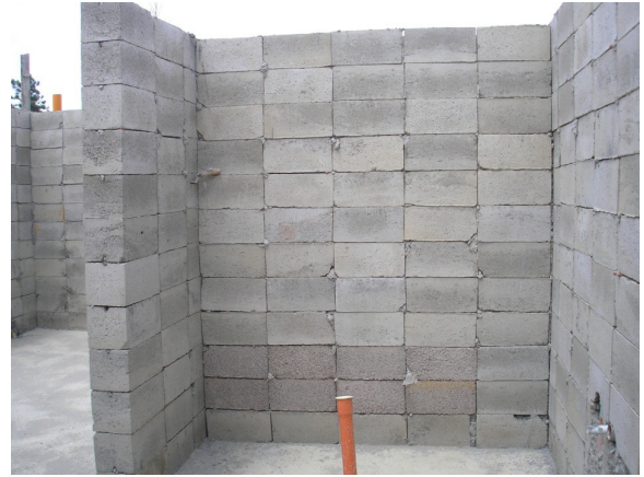
Figura 6. Edificio N° 17. Es un edificio frágil, constituido por paredes de bloques sin refuerzo metálico interior y sin la presencia de vigas y columnas
