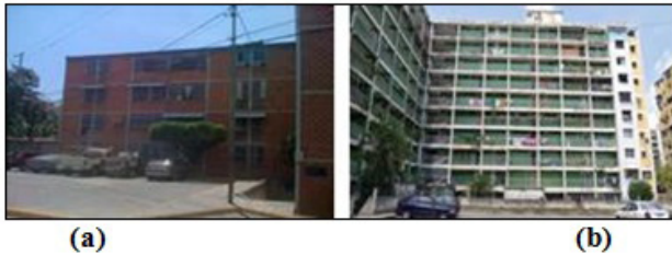
Figura 9. Tipologías vulnerables. (a) Edificios de muros de concreto armado en una dirección. (b) Edificios altos de pórticos de concreto armado proyectados antes de la norma COVENIN 1756 (2001)
