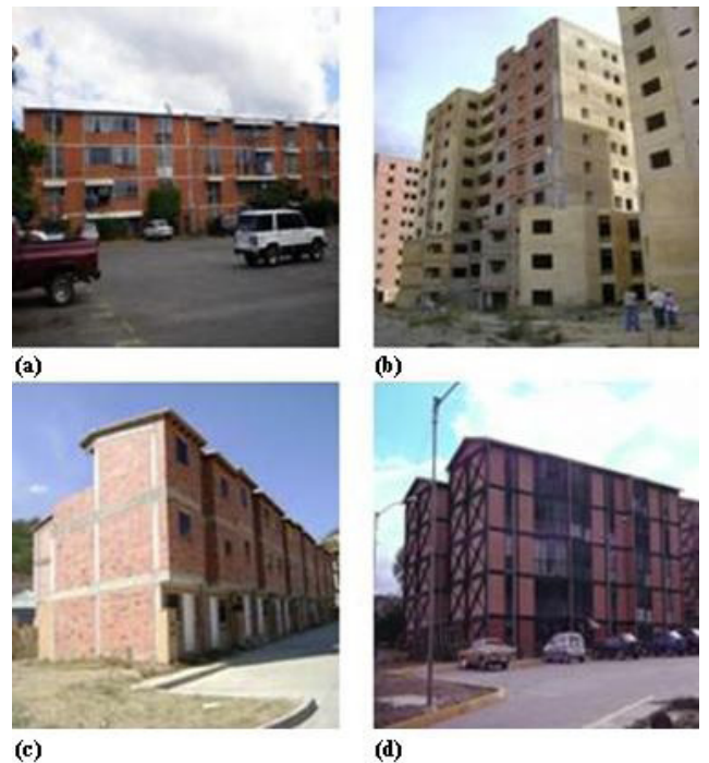
Figura 1. Algunas tipologías constructivas de las urbanizaciones. (a) edificios de muros de concreto armado en una dirección, (b) edificios de pórticos de concreto armado, (c) viviendas de 3 niveles de pórticos de concreto armado y (d) edificios de pórticos de acero arriostrados
