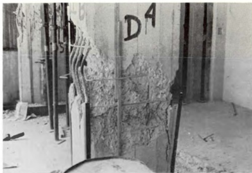
Figura 4. Detallado de columnas en edificios en Caracas afectados por el sismo de 1967: (a) Skinner, 1968; (b) Steinbrugge, 1967
