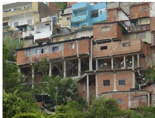
Figura 3. Construcciones populares en viviendas de Caracas incumplen las normas sismorresistentes
