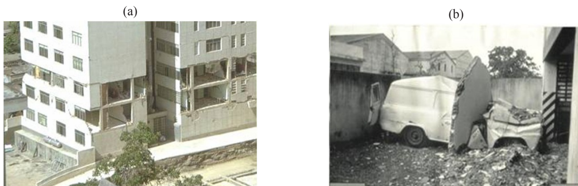
Figura 8. Caída de paredes en Los Palos Grandes durante el sismo de Caracas de 1967 (Steinbrugge, 1967)
