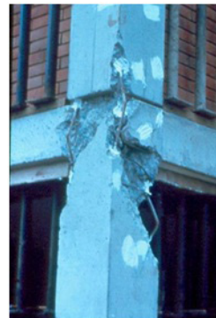
Figura 4. Detallado de columnas en edificios en Caracas afectados por el sismo de 1967: (a) Skinner, 1968; (b) Steinbrugge, 1967
