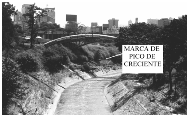
Figura 10. Vista general del cauce del río Guaire aguas abajo de Puente PV-UC, después de la creciente del 8 febrero 2005. Foto del 12 Febrero 2005.
