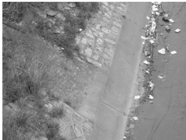
Figura 15. Igual a la figura 11 para el 21 de febrero de 2006, 3:36 PM HLV. Obsérvese que la cubierta de cemento ha sido reparada y que la vegetación es normal.
