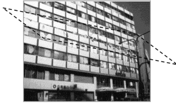
Figura 16. Colapso del quinto piso. (Débil) (Fuente: Vyacheslav, 2004)
