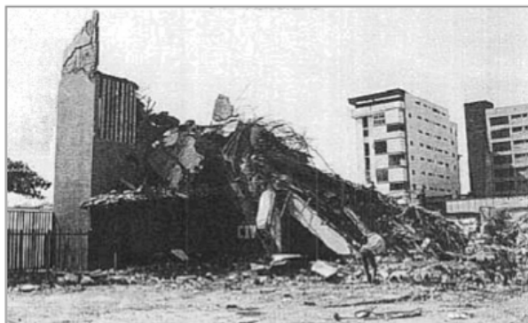
Figura 29. Edificio Miramar -Cumaná, después del terremoto de 1997 (Fuente: Hernández & López, 2007)
