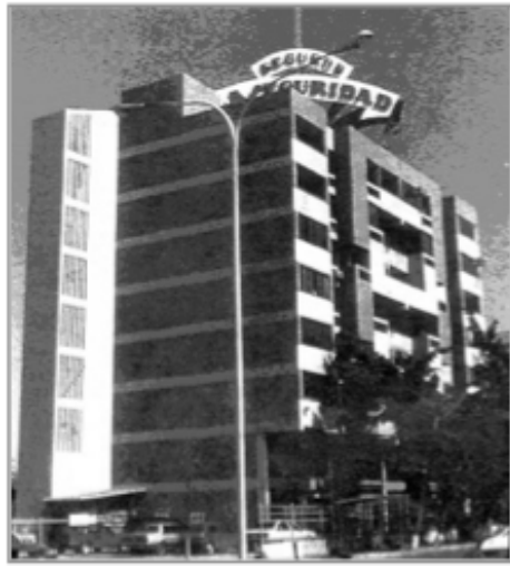
Figura 27. Edificio Miramar -Cumaná, antes del terremoto de 1997 (Fuente: Hernández & López, 2007)
