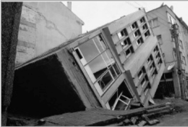
Figura 36. Fundación Superficial (Fuente: redbpncivil.blogspot.com )
