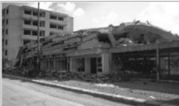
Figura 41. Licuefacción. México - 1985 (Fuente: facingyconst.blogspot.com/2007/08/daos )
