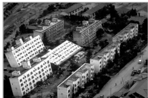
Figura 39. Licuefacción. Nigata-Japón-1964 (Fuente: facingyconst.blogspot.com/2007/08/daos )
