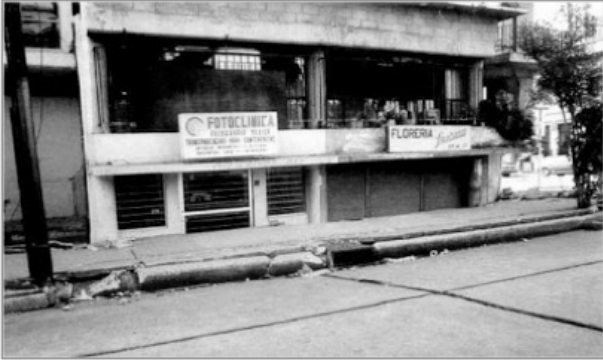
Figura 40. Licuefacción. México - 1985 (Fuente: facingyconst.blogspot.com/2007/08/daos )
