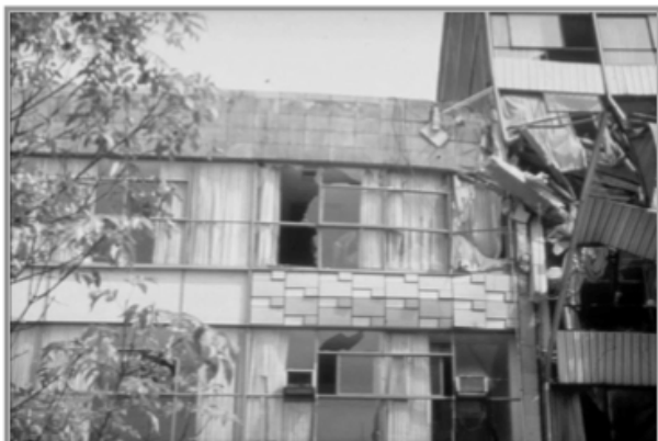
Figura 37. Choque entre edificios. Ciudad de México. (Fuente: www.proteccioncivil.org (1985))
