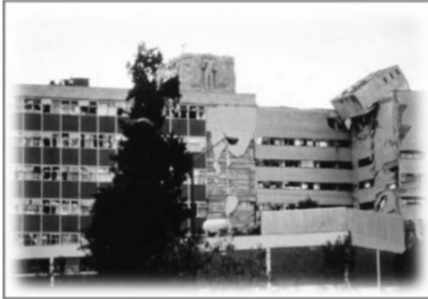
Figura 10. Tanques para agua en el techo de un hospital (Fuente: Cardona, 2004)
