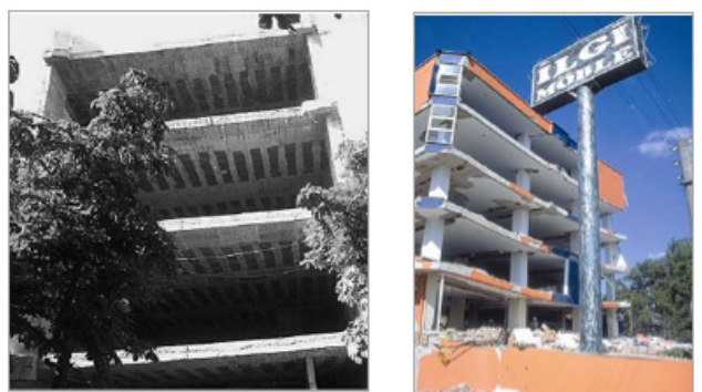
Figura 31. Ausencia de Vigas (Fuente: EERI, 1999)
