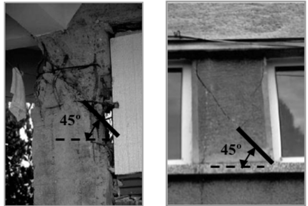
Figura 12. Falla frágil: Columna corta y poco refuerzo transversal (Fuente: Sezen et al. 2003)
