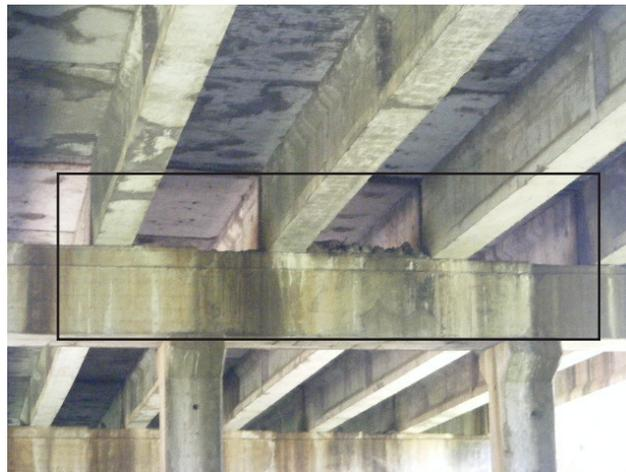
**Figura 15.** Vigas simplemente apoyadas sobre el cabezal de pila. Ausencia de trabas sísmicas y dispositivos de apoyo
