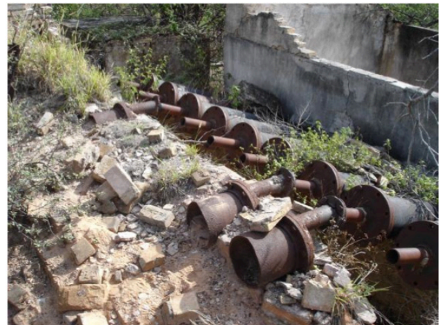
Figura 10. Ruinas del horno en 2007. Arriba: Bocas de alimentación de los hornos. Abajo: Retortas y chaquetas de enfriamiento para condensar el vapor de mercurio
