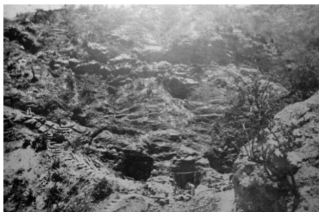
Figura 8. Trabajos mineros de San Jacinto en 1942. En la parte centro-inferior aparece la bocamina del túnel “Traviesa”, con un soporte de madera y un hombre al frente. Nótese una serie de escalones excavados en la ladera para acceder a las bocaminas superiores. (Tomado de López & Brineman (1943))
