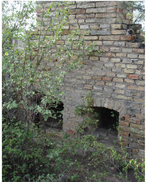
Figura 9. Horno de retortas tipo “Gould” para la extracción de mercurio. (Tomado de López & Brineman (1943: 52))
