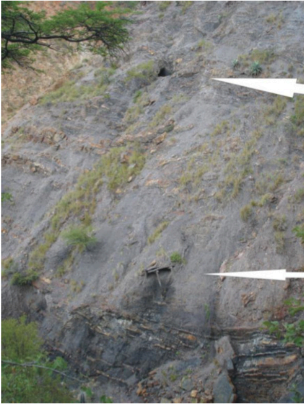
Figura 13. Vista de la ladera donde estuvieron los trabajos de 1941-1942. En la parte superior aparece la boca del “Trabajo N° 8” y abajo el túnel “Travesía”. La foto fue tomada en 2007 desde la margen izquierda de la Qda. Paja Amarilla (ver las ubicaciones en la Figura 7). Compárese esta fotografía con la Figura 8 en la cual se observa que para 1942 desde la bocamina “Travesía” partía un acceso con escalinatas hacia las labores superiores
