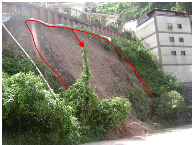
**Figura 4.** Deslizamiento de detritos (debris slide) en las rutas inter colinas de Santa Mónica. El material deslizado corresponde a botes de materiales sueltos o mal compactados, empujados sobre las laderas o taludes durante la urbanización del sector. La superficie del deslizamiento se encuentra a menos de 1 m de profundidad. Ver la ubicación aproximada en el punto número tres (3) de la Figura 1
