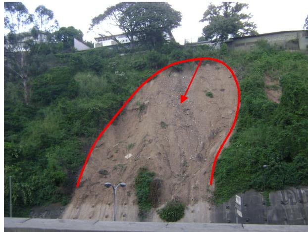
**Figura 3.** Deslizamientos de detritos (debris slide) en la Autopista de Prados del Este. El material de bote movilizado no supera un (1) metro de espesor. Ver la ubicación aproximada en el punto número dos (2) de la Figura 1
