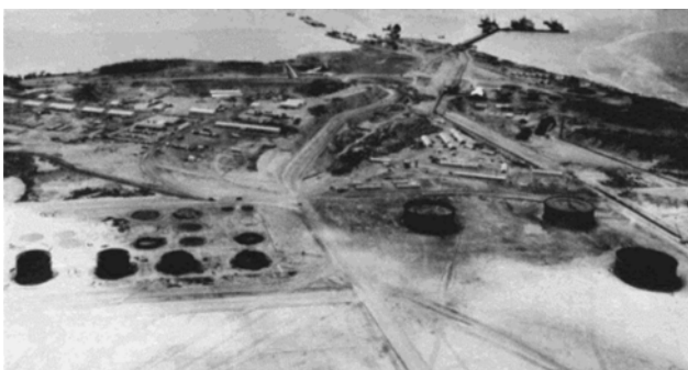
Figura 8. Construcción de la refinera en Amuay.
