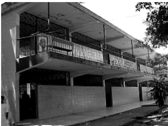
a) Fachada lateral
