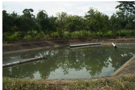
Figura 2. Laguna Facultativa de 20m X 30 m y profundidad 1,50m, vista aguas arriba, implementada en Caño Seco, Municipio Alberto Adriani, Zona Panamericana del Estado Mérida.
