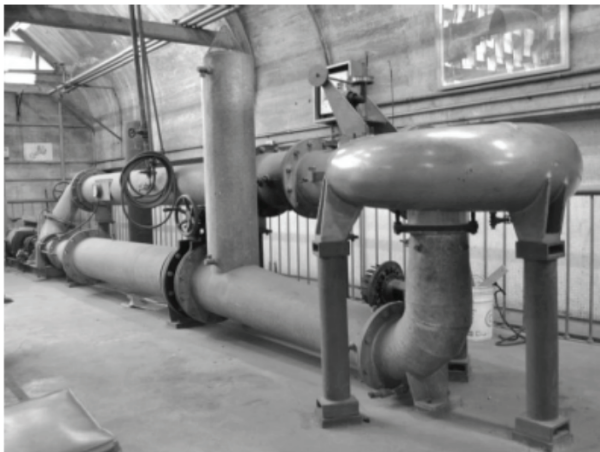
Figura 1. Banco de pruebas de la turbina Kaplan. Laboratorio de Energética, Escuela de Ingeniería Mecánica, UCV
