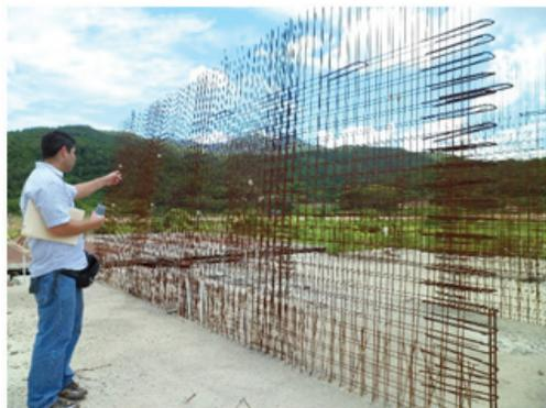
(b) Mallas de acero en muros.
