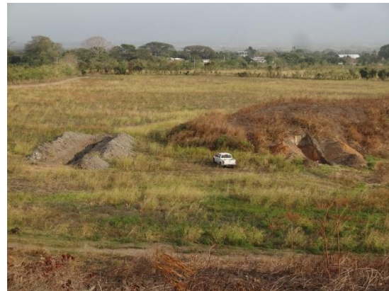
Figura 17. Vista oblicua general de las trincheras excavadas en la localidad de Don Ramón (estado Yaracuy), a través del segmento Boc-e de la falla de Boconó, en el año 2015, cuyos análisis no han sido aún realizados por falta de fondos para cubrir las dataciones radiocarbónicas.
