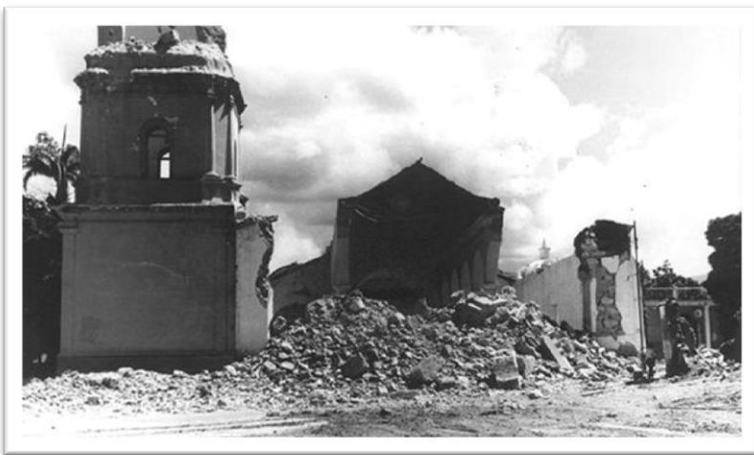
Figura 4. Daños en la población de El Tocuyo (Fuente: El Impulso, Barquisimeto, 4 de agosto de 1950).
