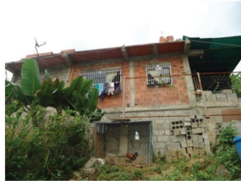
b. Vivienda de tipo estructural mixto, losa de tablon
