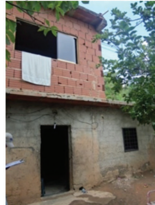
b. Vivienda de tipo estructural mixto
