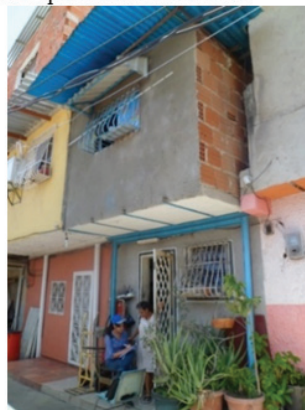
b. Vivienda de tipo estructural mixto
