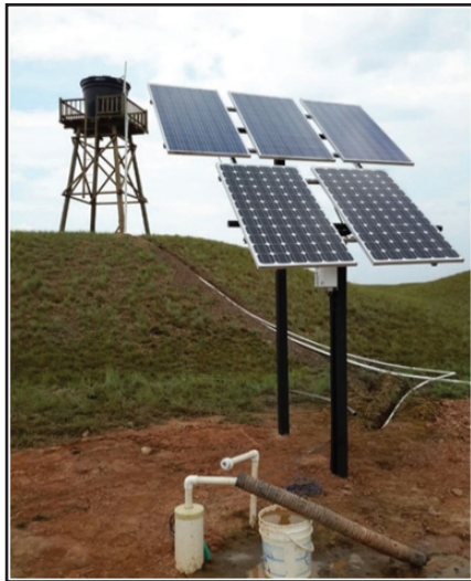
Figura 6. Instalación del campo de captación para alimentación de cargas eléctricas, montaje de bombeo subterráneo y almacenamiento de agua en Llanos Orientales de Colombia
