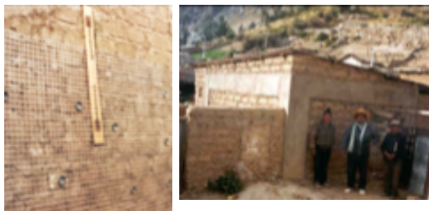
Figura 1. Malla electrosoldada, instalación y recubrimiento
