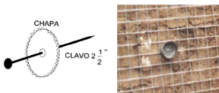
Figura 13. Instalación de la malla y fijación con clavo y chapa
