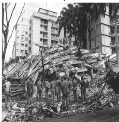
Figura 6. Los edificios derrumbados en Caracas en 1967 tenían una planta baja débil debido a la interrupción de las paredes de relleno de los pisos superiores: (a) Archivo FUNVISIS; (b) Steinbrugge, 1967
