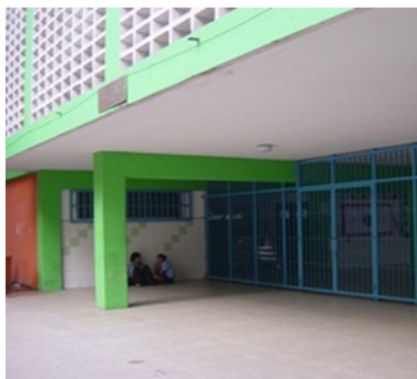
Figura 5. Edificios con carencia de planos resistentes bien definidos en una o dos direcciones horizontales
