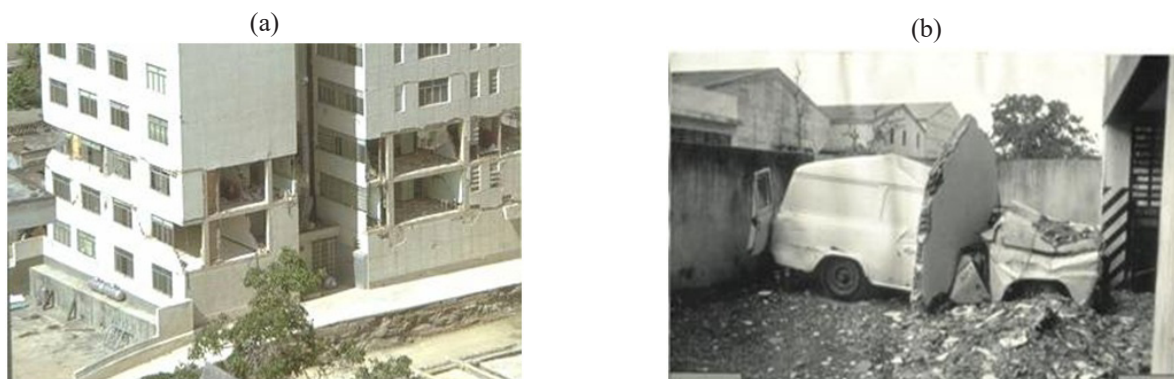
Figura 8. Caída de paredes en Los Palos Grandes durante el sismo de Caracas de 1967 (Steinbrugge, 1967)
