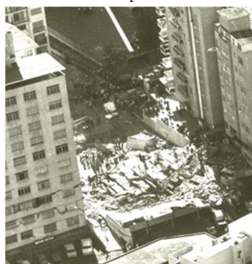
Figura 6. Los edificios derrumbados en Caracas en 1967 tenían una planta baja débil debido a la interrupción de las paredes de relleno de los pisos superiores: (a) Archivo FUNVISIS; (b) Steinbrugge, 1967
