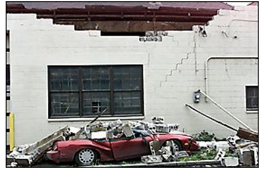
Figura 11. Placa e imagen colocada en edificios antiguos en California (Mays, 1999b)
