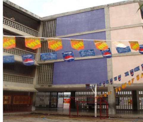
Figura 13. Edificio escolar del tipo Módulo Base, vulnerable a la acción de los sismos
