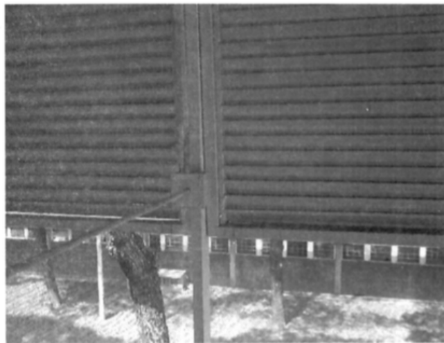
Figura 11. Detalles de protecciones solares y en fachada este, ejemplo adecuado de arquitectura tropical
