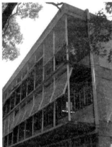
Figura 11. Detalles de protecciones solares y en fachada este, ejemplo adecuado de arquitectura tropical
