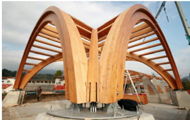
Figura 13. Arcos triarticulados de semicírculo con madera laminada.
