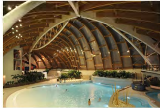
Figura 3. Espacio resuelto con elementos estructurales de madera laminada encolada.
