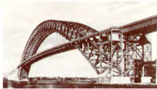
Figura 6. Analogía entre la representación del diagrama de momento flexionante de una viga horizontal empotrada en los extremos y la estructura empleada por Ammann & Cass, en 1931, en la solución del puente metálico de Bayonne para salvar una distancia grande entre los apoyos.
