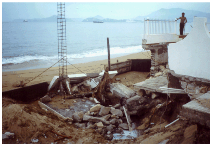
Figura 6. Casa destrozada por oleaje de tormenta. Colonia las Brisas Manzanillo Col., (Sep. 2000).
