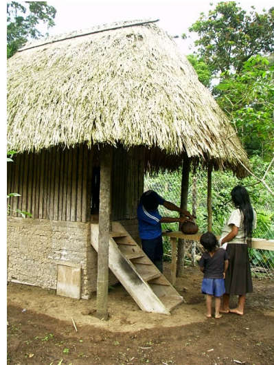
Figura 7. Inodoro seco separador de orina
