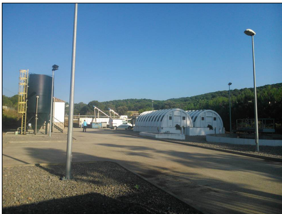
Figura 9: Vista General de la Planta
