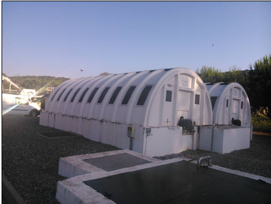
Figura 12: Biodiscos rotatorios de la E.D.A.R.
