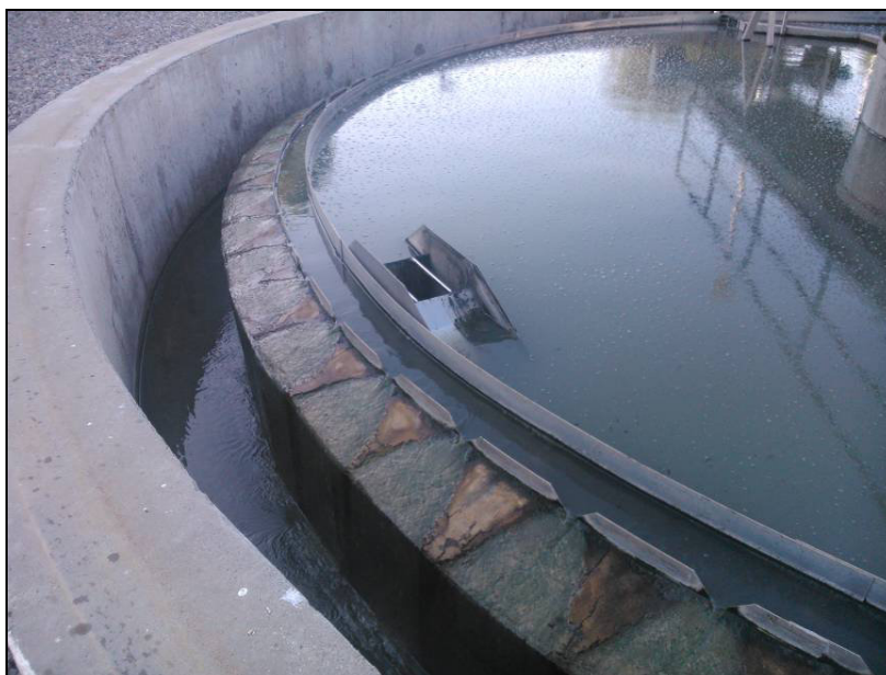
Figura 14: Canaleta perimetral de recogida, junto al decantador secundario
