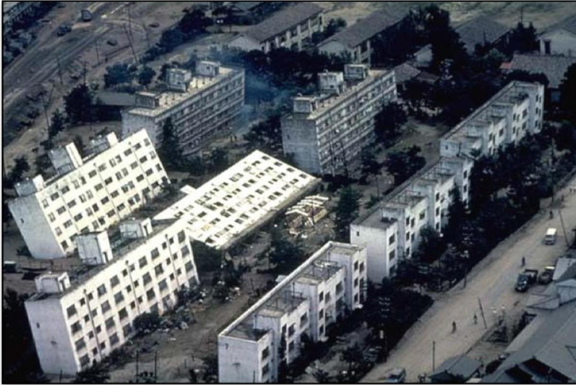
**Figura 2.6 Edificaciones Colapsadas Terremoto de Kobe Japón. Fuente: (Japón pop 2008).**
