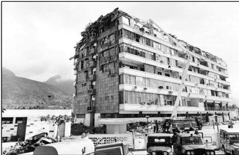
**Figura 2.3 La Mansión Charaima. Caraballeda 1967. La estructura fue inicialmente concebida para seis (6) pisos y le fueron construidos cuatro (4) más, los cuales se vinieron abajo a causa del terremoto. Fuente: (FUNVISIS 2010).**
