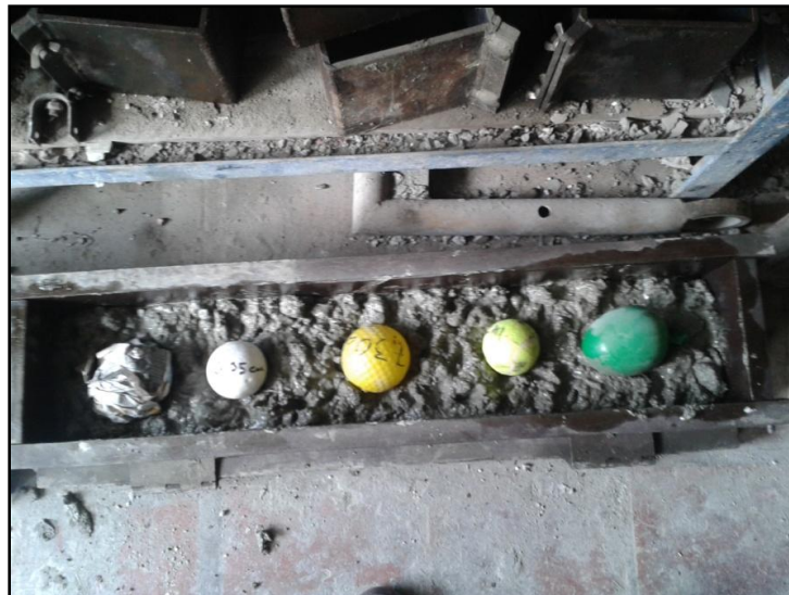
Figura 14. Vaciado de viga con vacíos esféricos.
