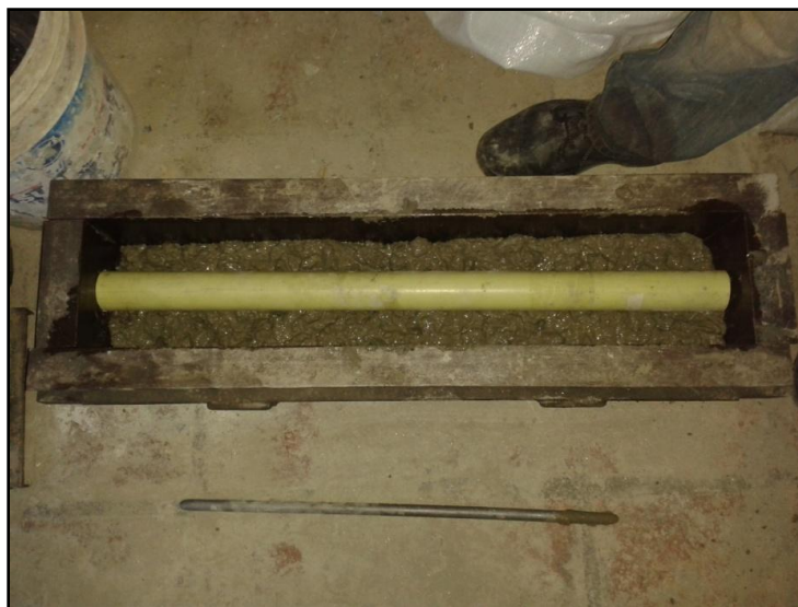
Figura 16. Vaciado de viga con vacío tubular continuo.
