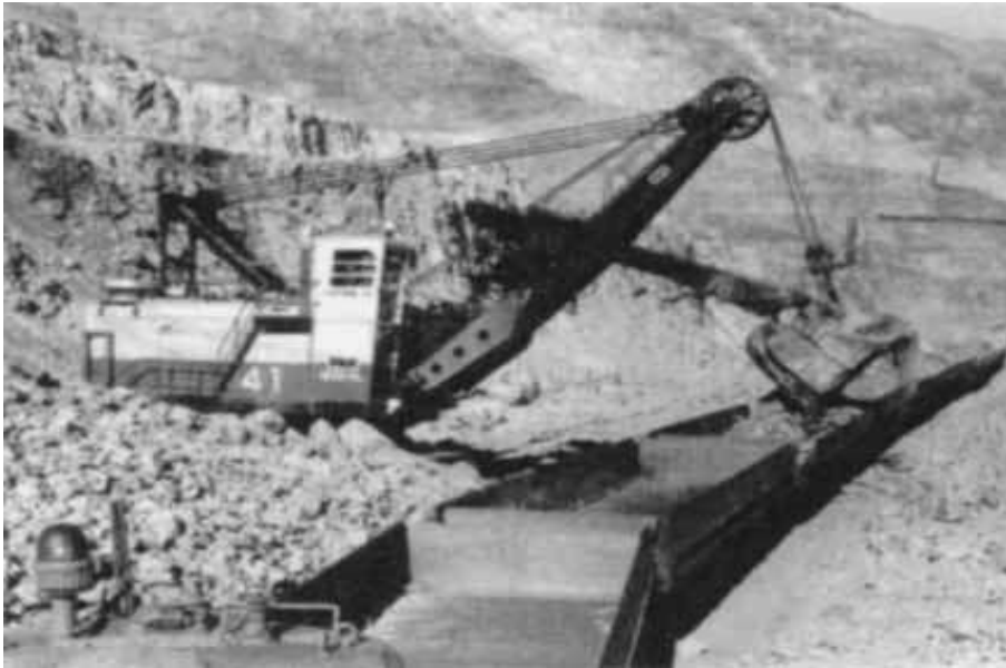
Pala cargando un tren articulado en una mina a cielo abierto
