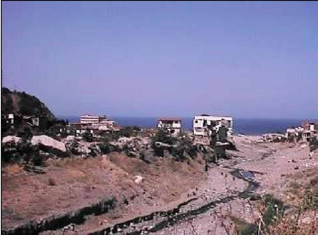
Figura 2.2. Fotografía con rumbo 340°, mostrando un panorama del abanico aluvial del río Uria y el urbanismo que sobrevivió a las crecidas de diciembre de 1999.
