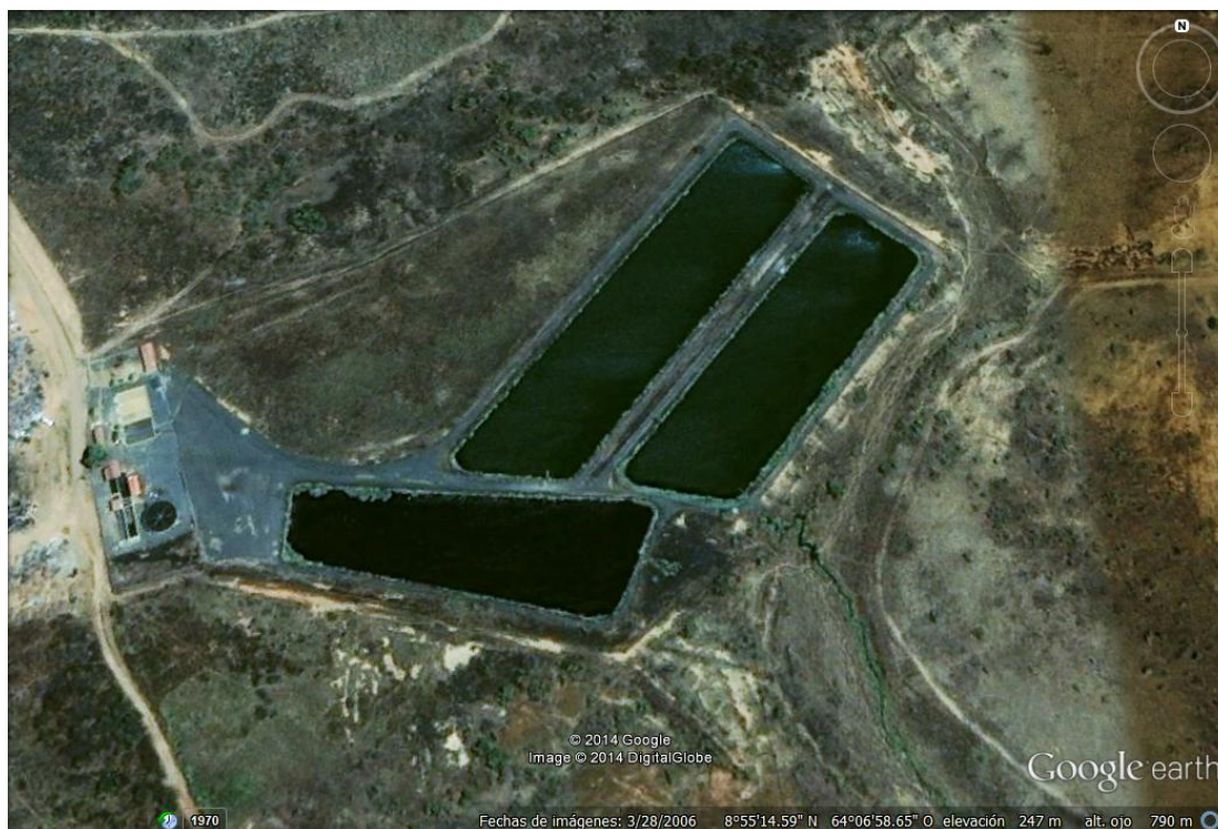
Figura N° 1. Vista aérea de planta de tratamiento de las comunidades “Los Próceres” y “La Victoria” del Distrito San Tomé.
