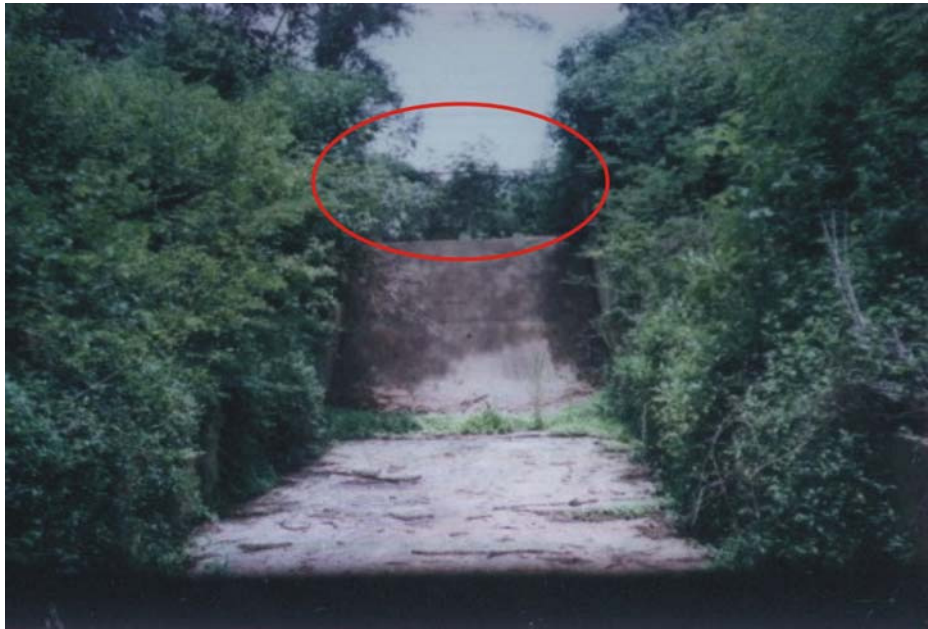
Foto 5.15. Cimacio y canal rápido. Vegetación densa en los taludes del aliviadero. Embalse "El Andino".
