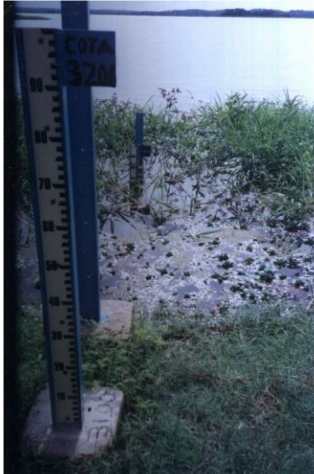
Foto 5.6. Miras en el embalse en buen estado y completas. Embalse "El Cuji".
