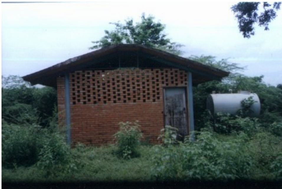
Foto 5. Instalación para la generación de energía (a base de Gasoil). No está en operación Embalse “El Andino”.
