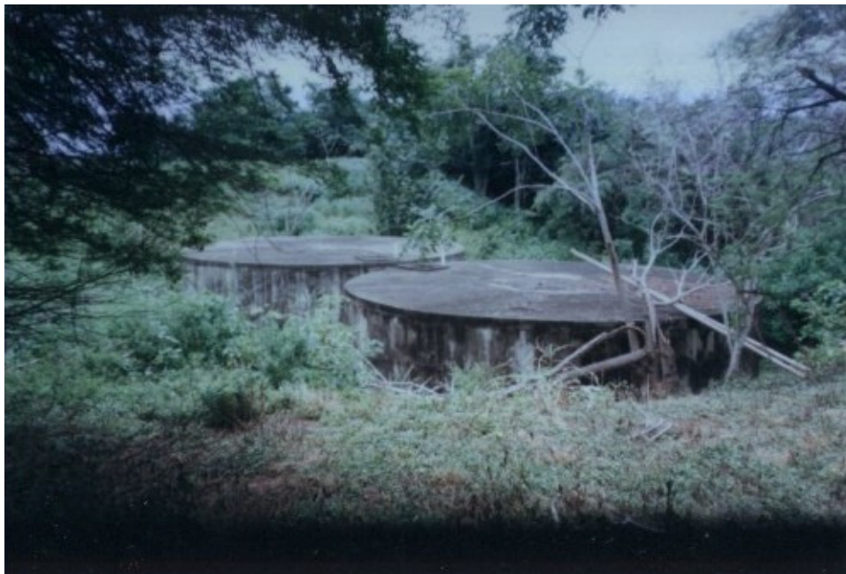
Foto 4. Tanques de agua potable para las instalaciones de la estación piscícola. No están en operación. Embalse "El Andino".
