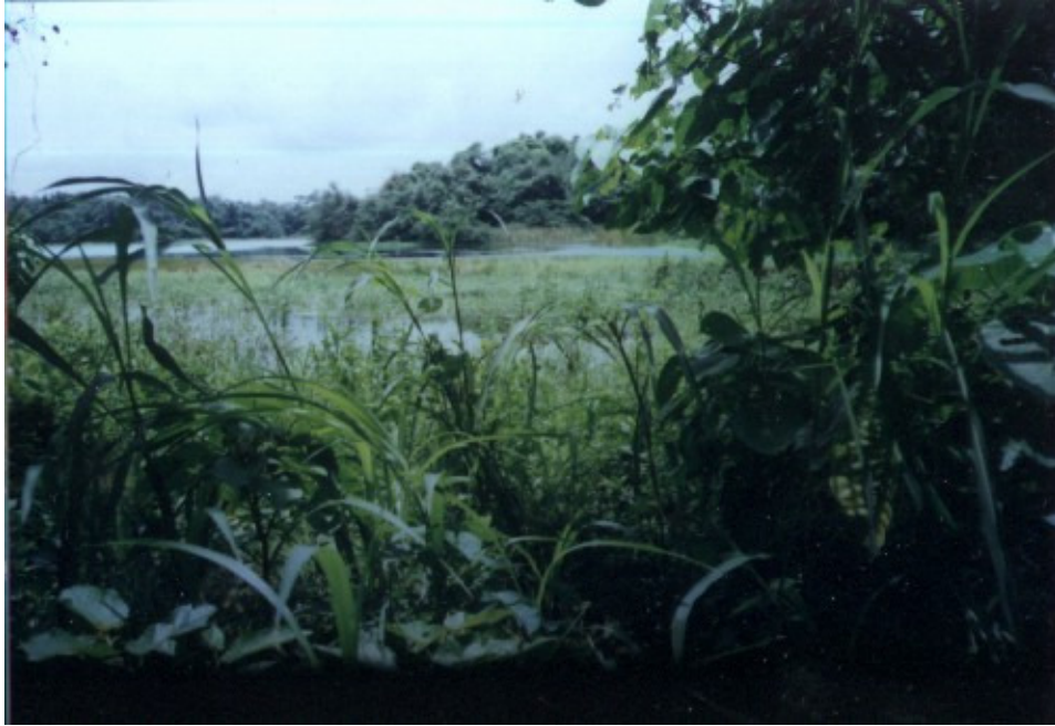
Foto 1. Canal de aproximación. Mirando hacia aguas arriba. Embalse "El Andino".
