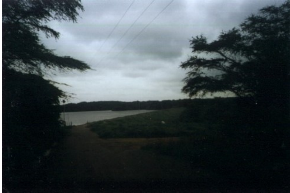
Foto 16. Talud de aguas abajo. Embalse "El Cují".
