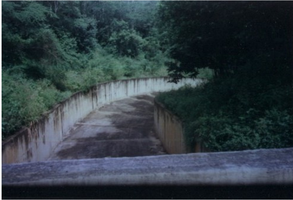
Foto 5.4. Canal rápido del aliviadero en buen estado. Embalse “El Cujj”.
