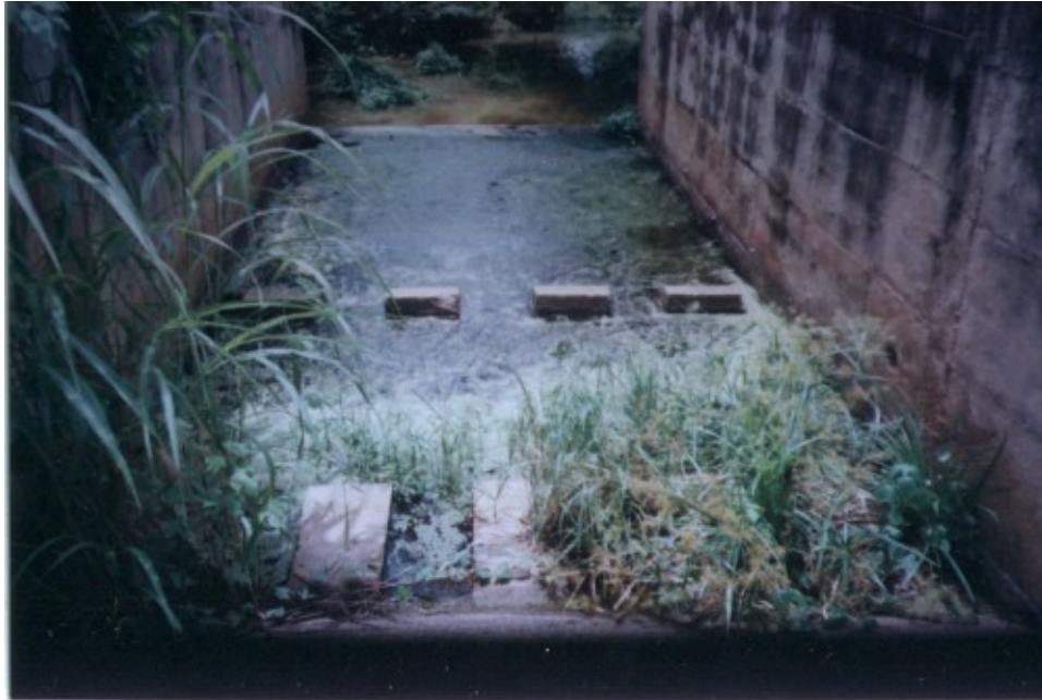
Foto 5.16. Pozo disipador con poca vegetación. Embalse "El Andino".
