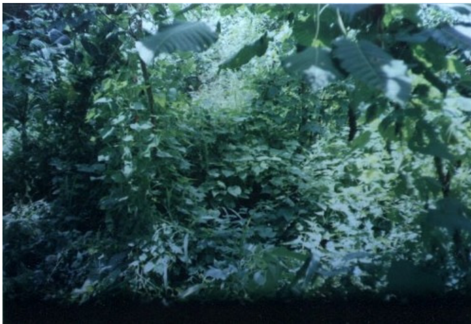
Foto 5.13. Parados en el cimacio viendo el canal de aproximación, con vegetación muy densa. Embalse “El Andino”.
