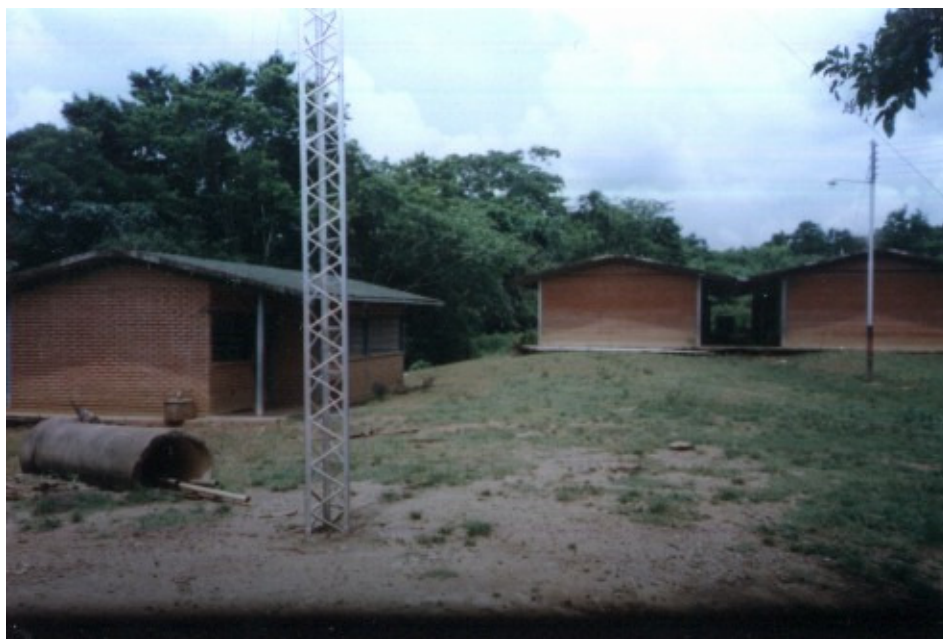
Foto 6. Infraestructuras para la estación piscícola y el encargado del embalse. Embalse “El Andino”.
