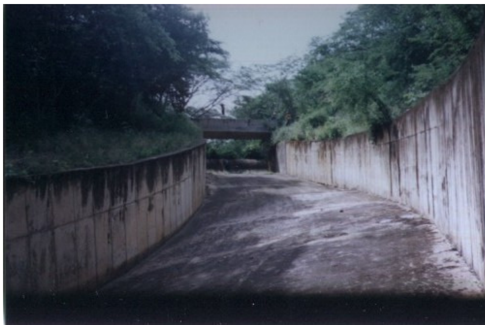
Foto 10. Rápido, cimacio y taludes laterales del aliviadero. Embalse “El Cují”.
