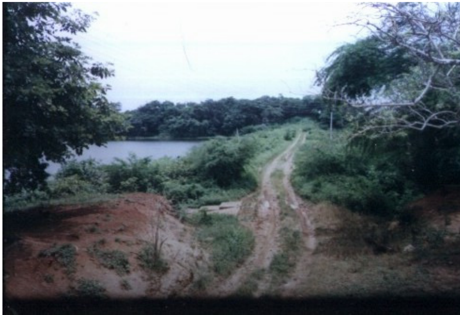
Foto 5.19. Cresta sin asfaltar y taludes con abundante vegetación. Embalse "El Andino".
