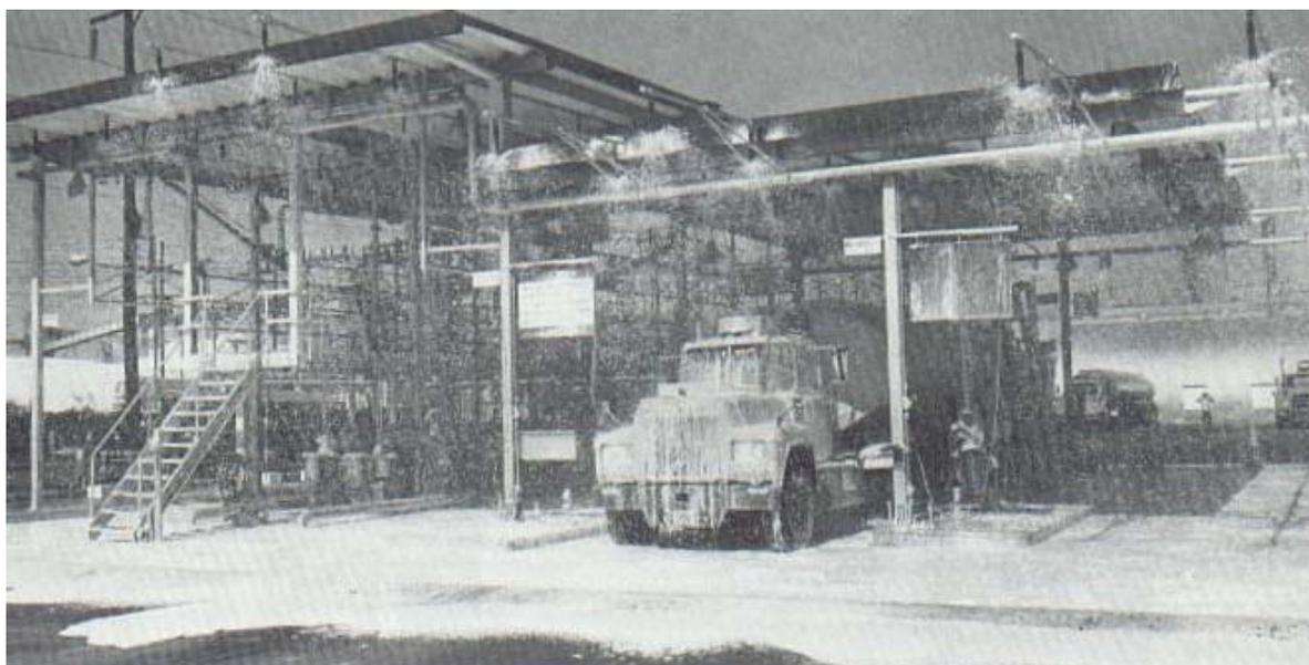
Figura 3.19 Activación de un sistema contra incendios para el llenado de camiones.
