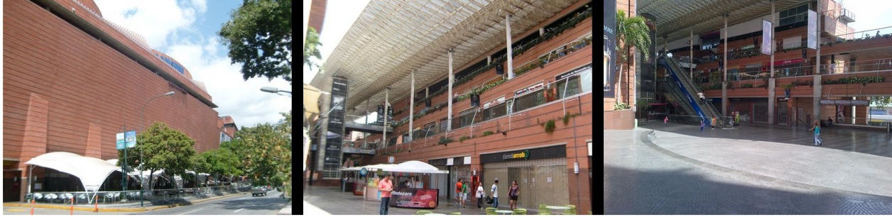
Fotos 4, 5 y 6. Centro San Ignacio. Fachada avenida Blandín, fachada interna de locales, espacio central
