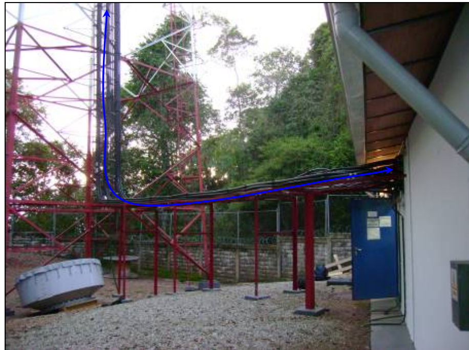
Vista de la escalerilla Torre-caseta / Recorrido de Guía de Onda
