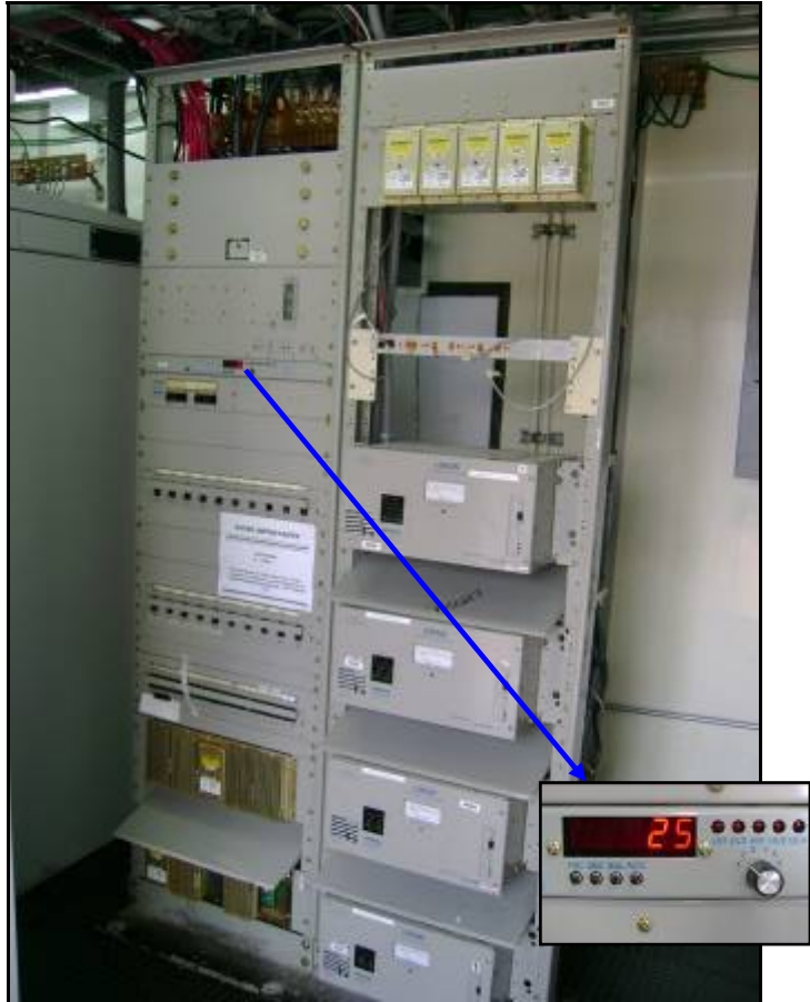
PDB LORAIN @ -48Vdc y +24Vdc. Consumo actual.
