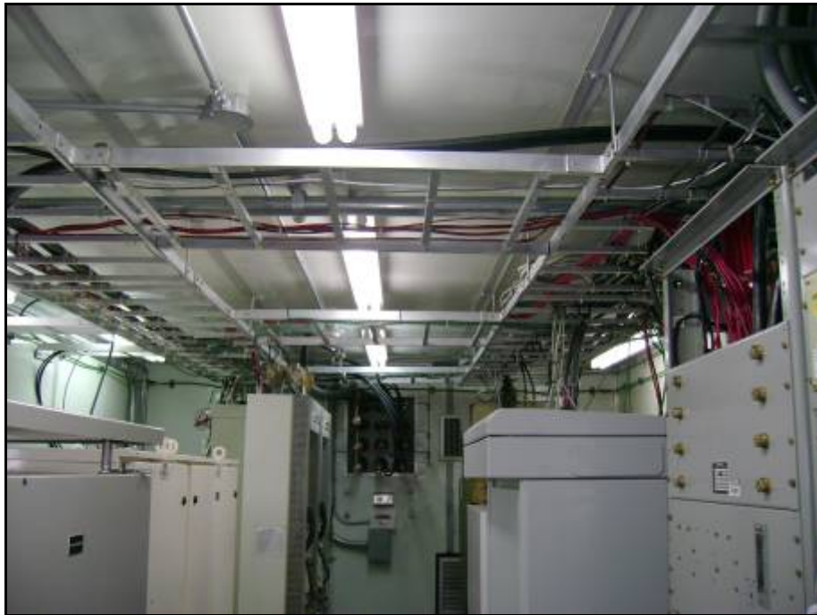
Vista general de la sala.
