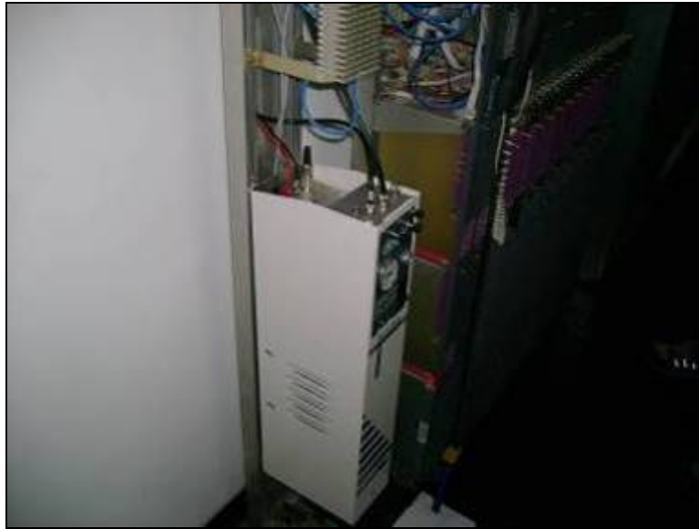
Presurizador Delair con una boquilla disponible
