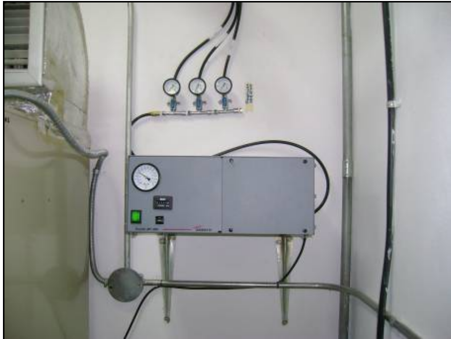
Presurizador existente en la sala. Se debe agregar una nueva boquilla para la instalación.
