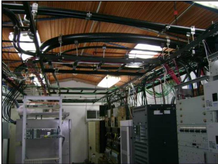
Vista general de la sala.
