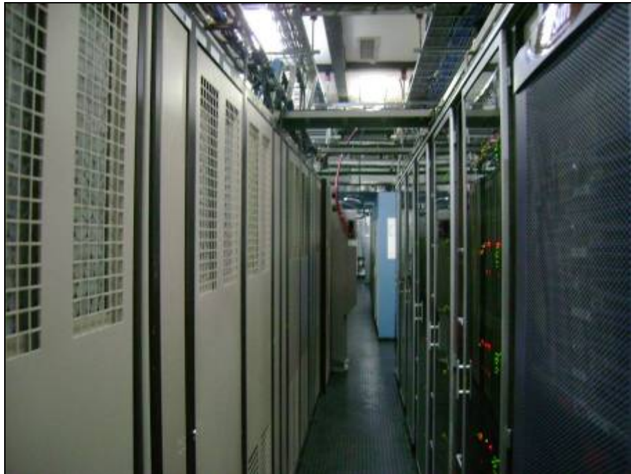
Vista General de la Sala
