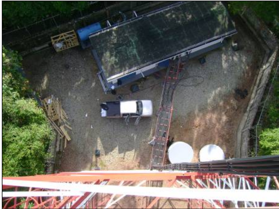
Vista general de la estación CERRO AZUL.
