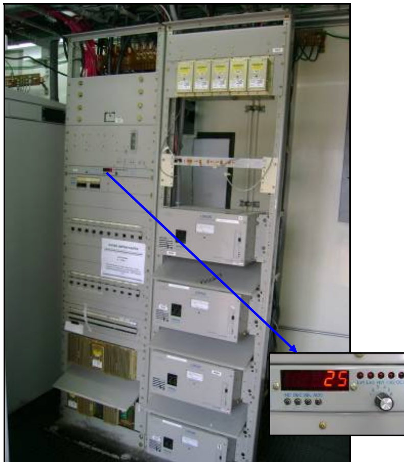
PDB LORAIN @ -48Vdc y +24Vdc. Zoom display de amperaje.
