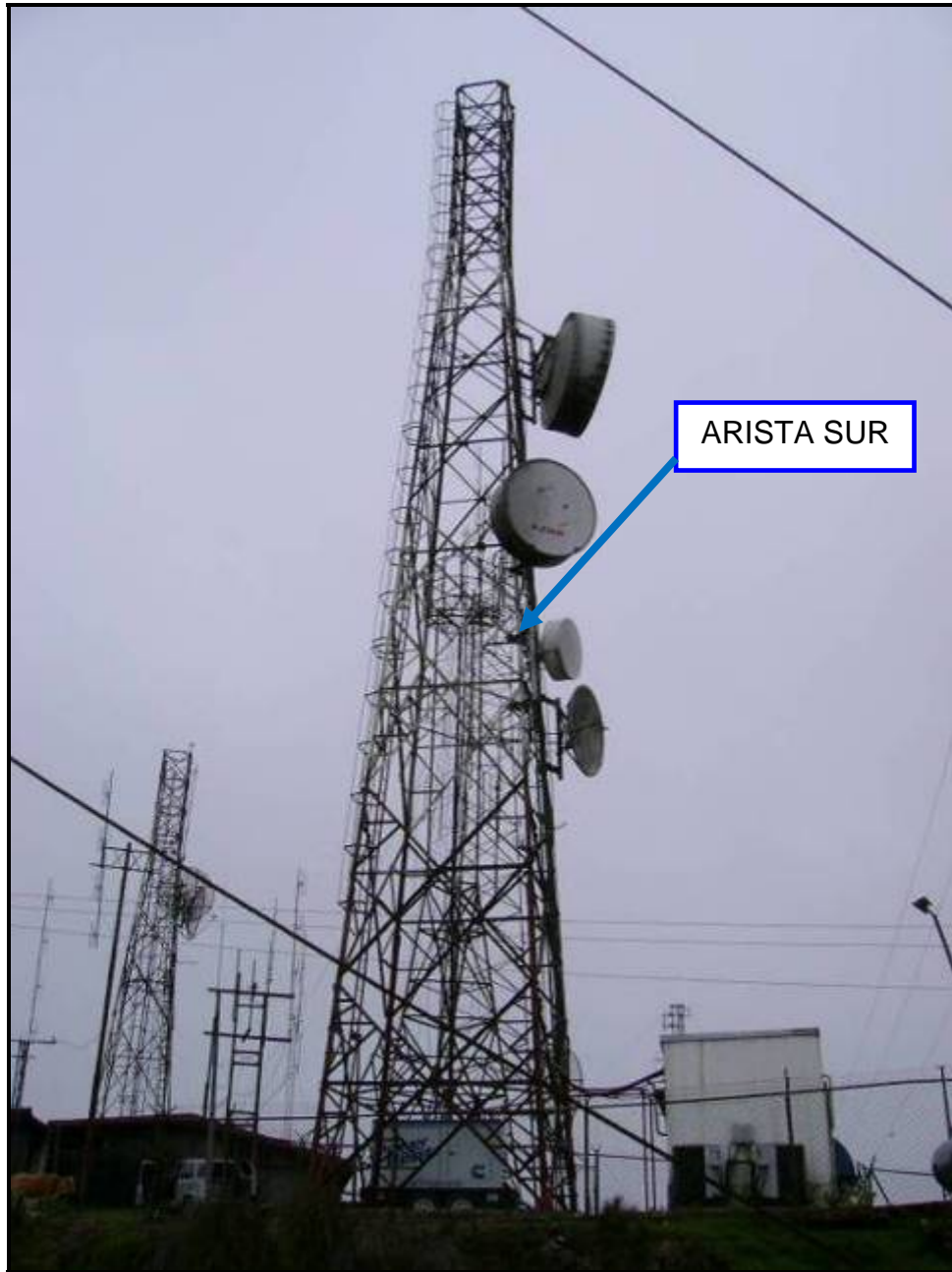
Vista general de la torre a utilizar
