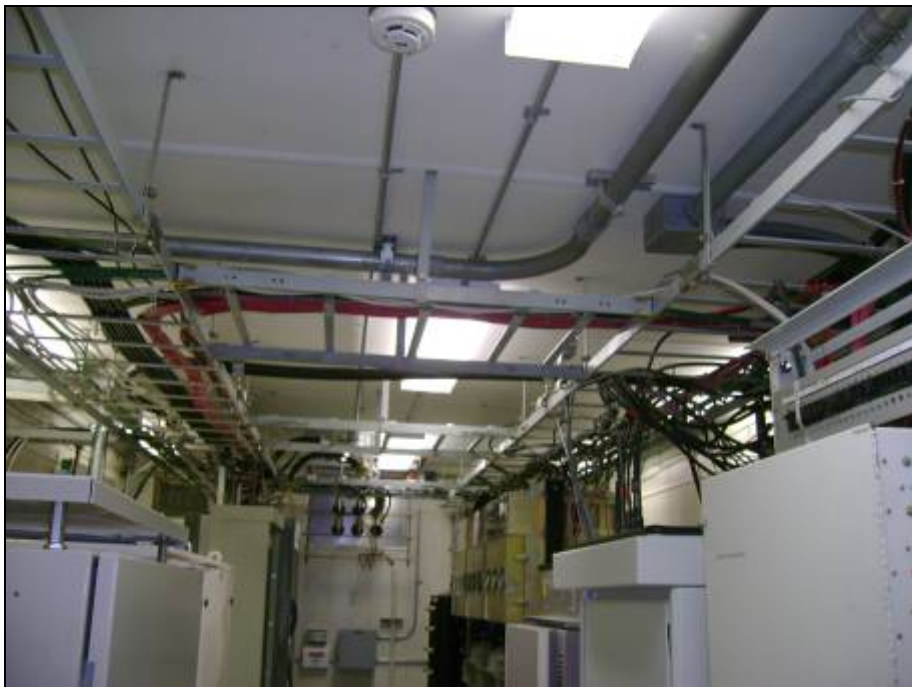
Vista general de la sala
