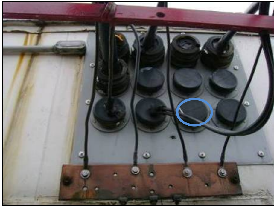
Vista exterior del pasamuros, barra EGB y ducto propuesto.
