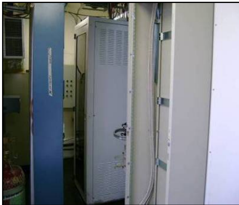
Vista general de la sala.
