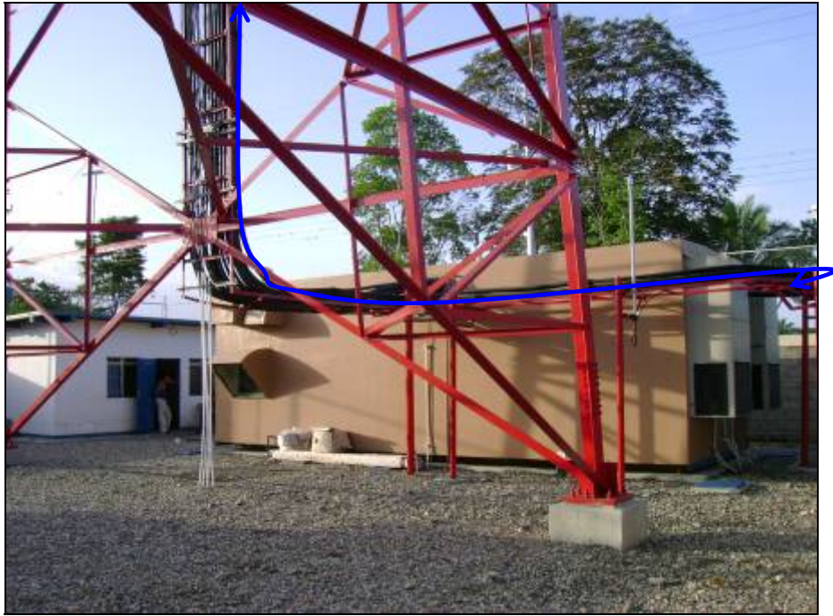
Recorrido vertical y horizontal de Guía de Onda
