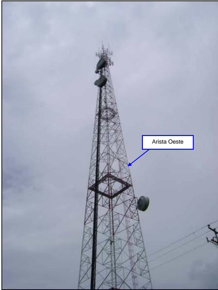
Vista general de Torre a utilizar
