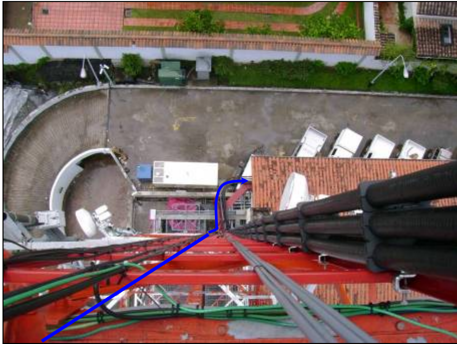
Vista de escalerilla vertical con disponibilidad y recorrido de Guía de onda.
