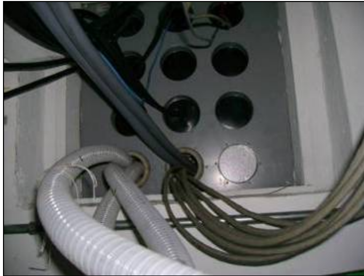
Vista interna del pasamuros a utilizar con disponibilidad
