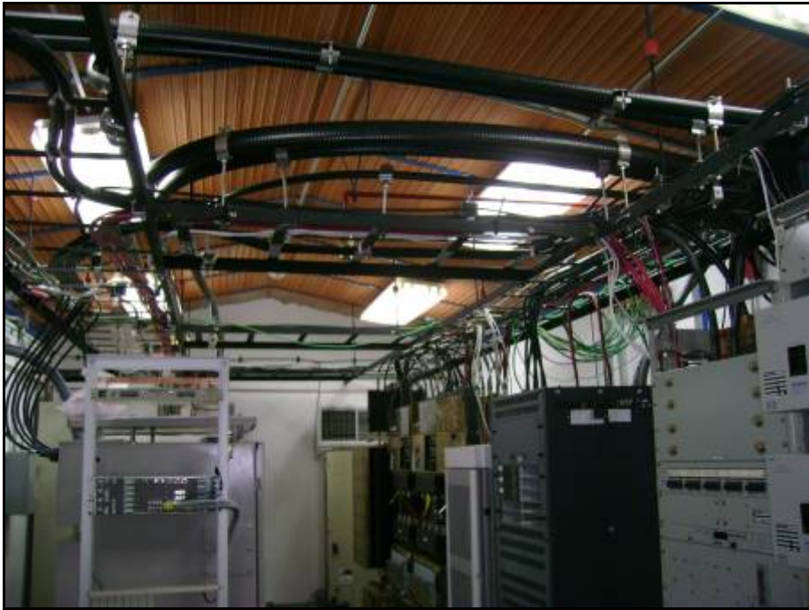
Vista general de la sala.
