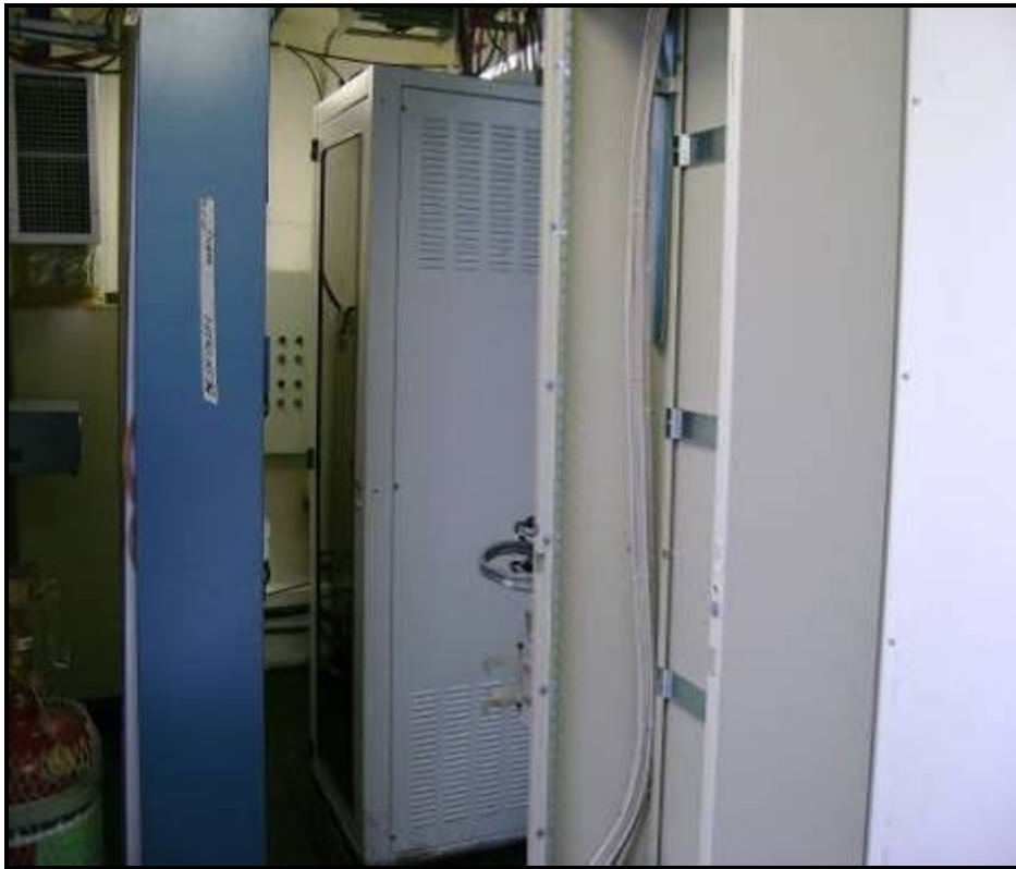
Vista general de la sala.
