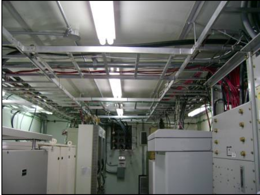
Vista general de la sala.
