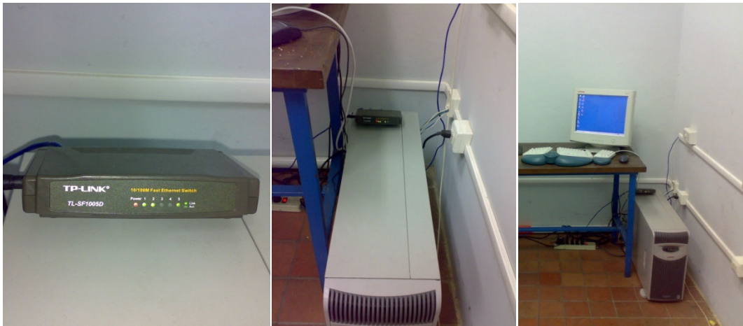
Figura 28. Instalación del Switch.
