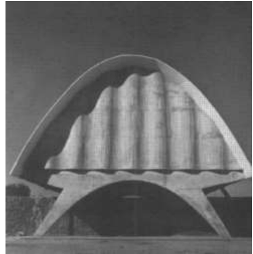
Una membrana de concreto armado de 1,5 centímetros de espesor.
