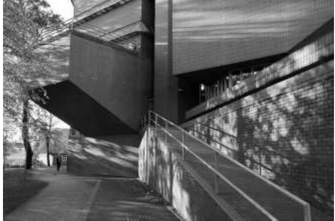
La rampa de entrada demasiado empinada
