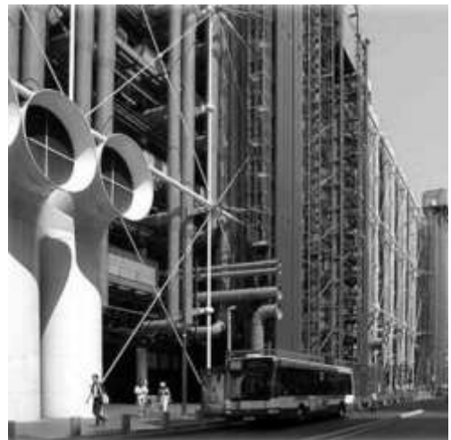
La estructura y las tuberías de diversas instalaciones a la vista del público
